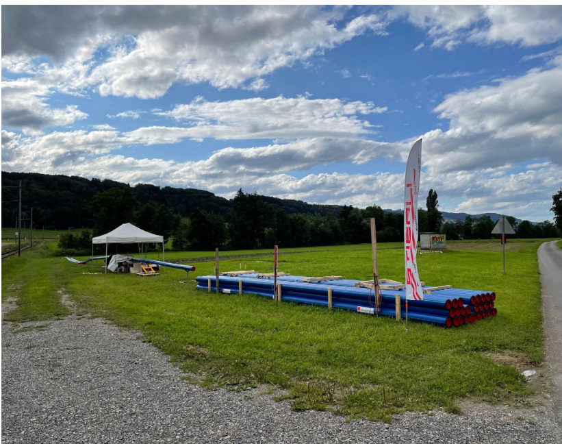
Rohrelemente für die Trinkwasser Notverbundleitung
